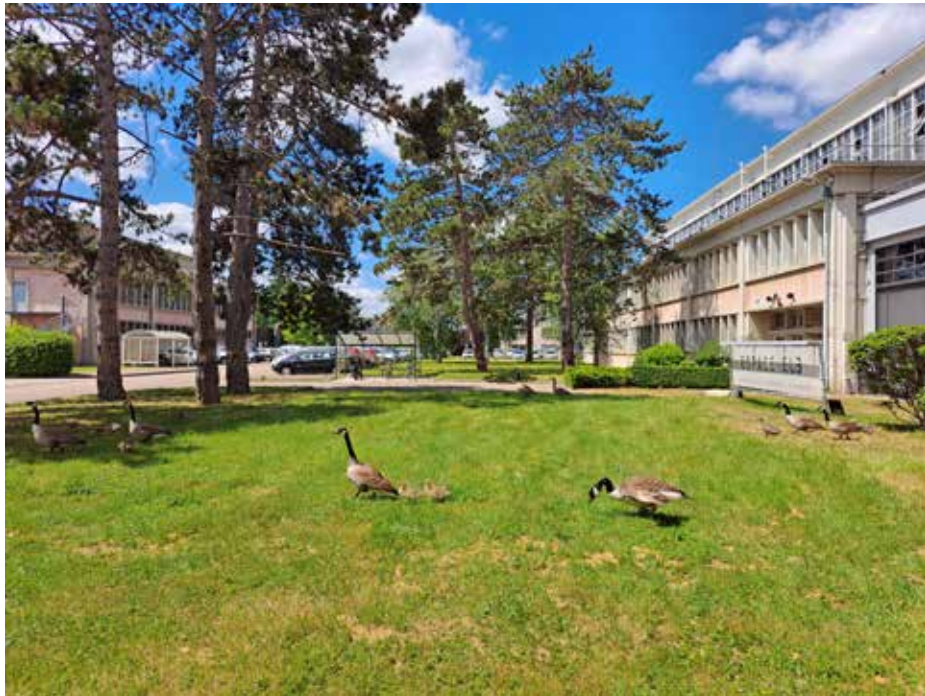
Vue extérieure dans l'enceinte du CEA de Saclay
